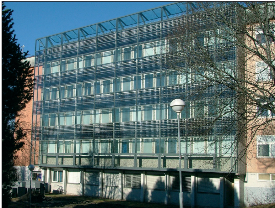
Solcelleveggen ved NTNU
