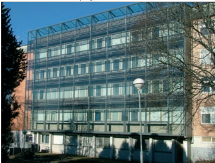
Solcelleveggen ved NTNU
