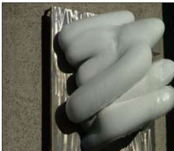
En fordamper for en varmepumpe ved Kjelhuset på NTNU Gløshaugen. Kunstverket er laget av Carl Nesjar
