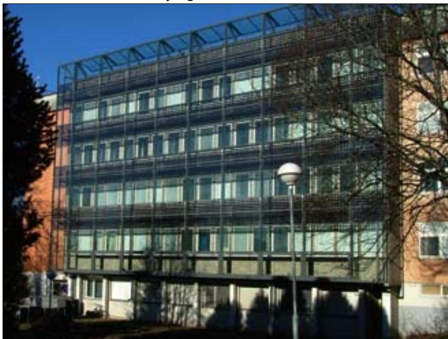
Solcelleveggen ved NTNU
